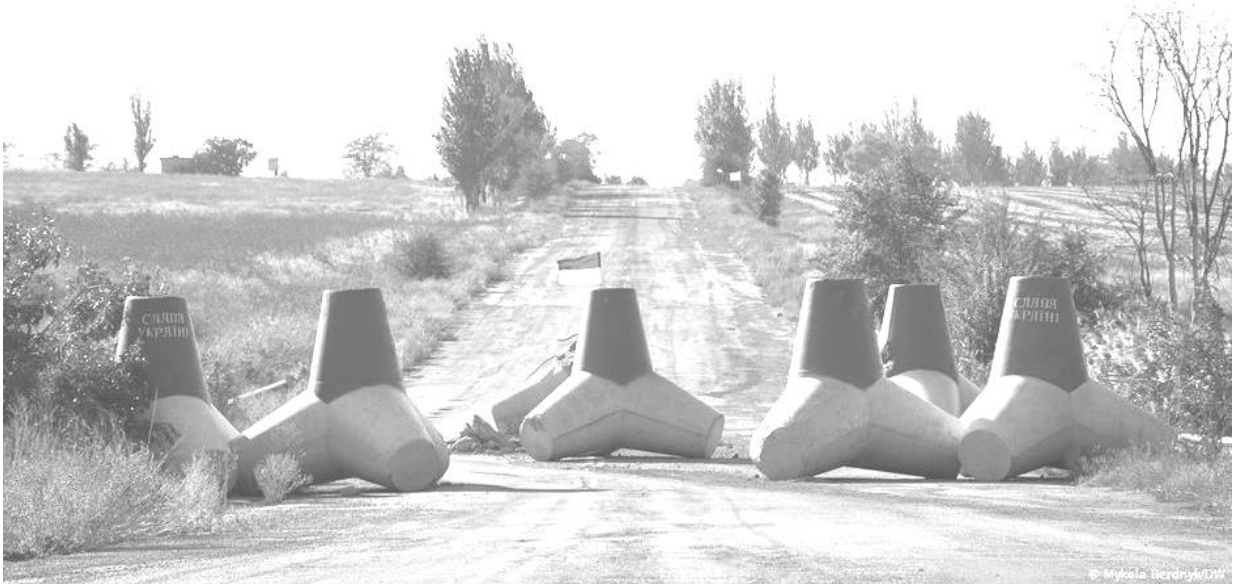
Рис. 61. Хвилерізи у якості протитанкових загороджень
