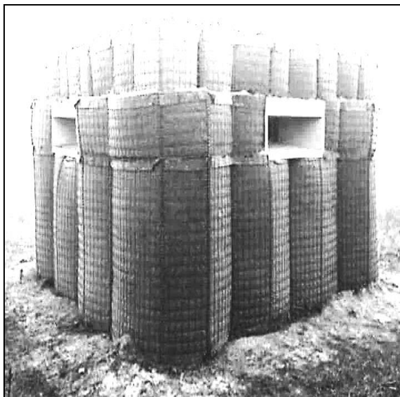
Рис.24. Мобільна габійна конструкція “Гарда-3”
