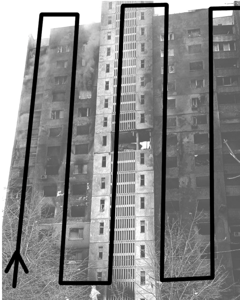
Рис. 29. Обліт фасаду висотної будівлі.
