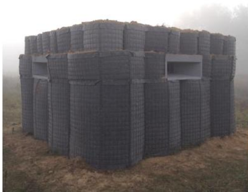
Рис.9.9. Мобільна габійонна конструкція МГК «Гарда - 3»
